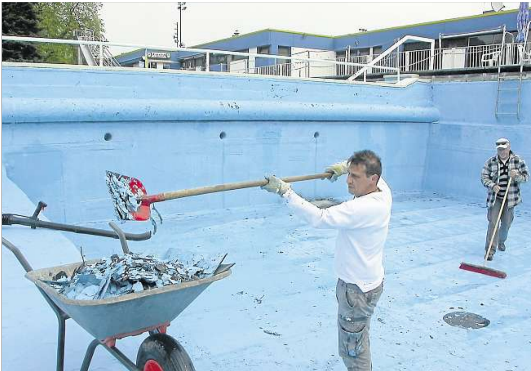
Entfernen die Teerblasen und die alte Farbbeschichtung im Freibadbecken (von links): Die städtischen Mitarbeiter Frank Funk und Peter Schuck. Foto: Dieter Deul
